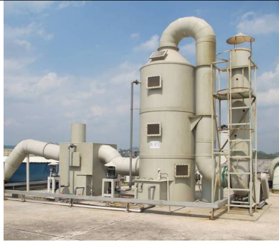
图3.2-2酸碱性废气处理系统照片
